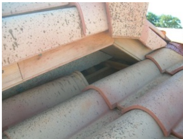
Figure 7 – Tuile « oubliée » lors de la pose...
