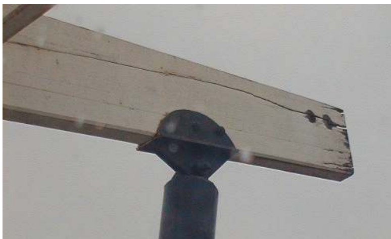
Figure 18 - Fixations de pannes arrachées
