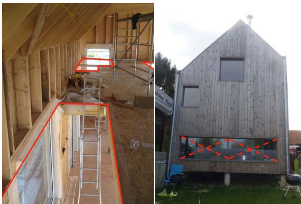
Figure 22 – Trop d'ouvertures nuit à la stabilité
