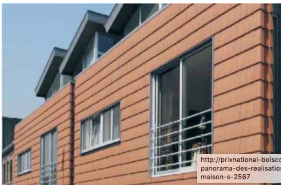
Figure 6 - Façade mixte avec revêtement en tuiles
