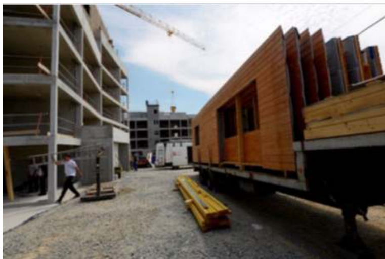
Figure 5- Mise en œuvre de façades à ossature bois sur structure béton
