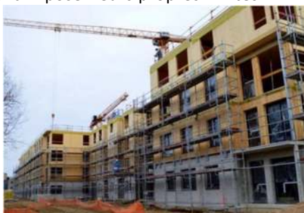
Figure 3 – Bâtiment de 140 logements construit en CLT dans l'Essonne
