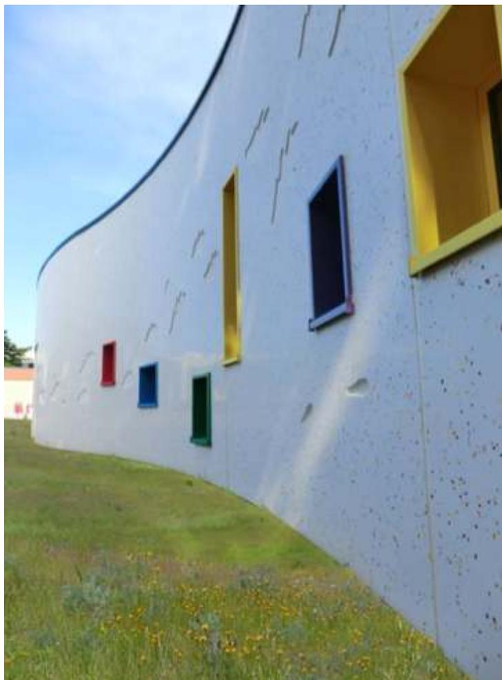
Figure 11 – Mur courbe à coffrage intégré
