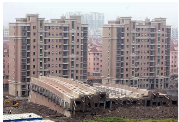
Fig.33-Shanghai-Eroulement d'un bloc R+10 par suite de la rupture de pieux
