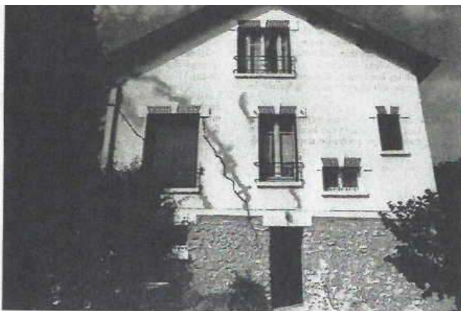
— (Cliché SIMESOL). La fissure de l'année 1985 a été colmatée, on a repris en sous-œuvre le pavillon partiellement au moyen de puits trop courts ... et en 1989 une nouvelle fissure, parallèle à la précédente est apparue. Pavillon situé à Montgeron (Essonne) et fondé sur les argiles vertes.
