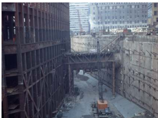
Fig.27 Paroi moulée; vue des têtes de tirants à droite
