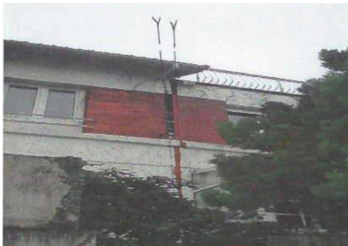
— (Cliché SIMESOL). La fissure de l'année 1985 a été colmatée, on a repris en sous-œuvre le pavillon partiellement au moyen de puits trop courts ... et en 1989 une nouvelle fissure, parallèle à la précédente est apparue. Pavillon situé à Montgeron (Essonne) et fondé sur les argiles vertes.
