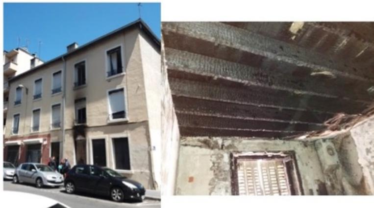
Figure 3 – le péril provoqué par un incendie de plancher
