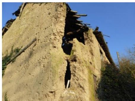
Figure 22 – effondrement partiel d'un mur de pisé
