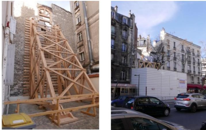
*Figure 9 – L'importance des étaitements et des protections de qualité*
