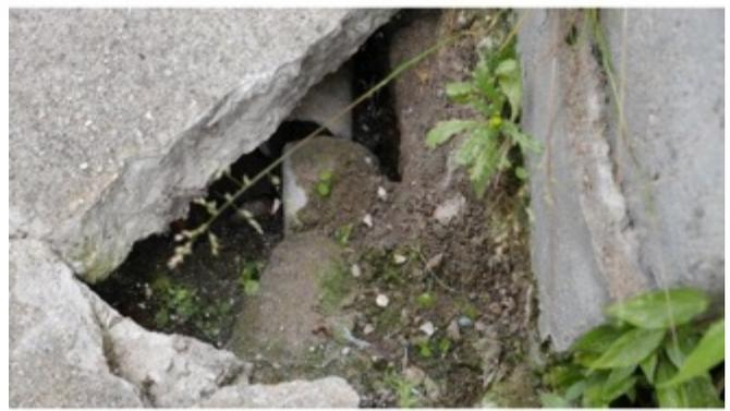
Figure 7 – Conséquences d’une rupture de canalisation enterrée
