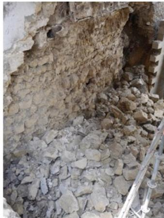
Figure 6 – Une excavation sans protections
