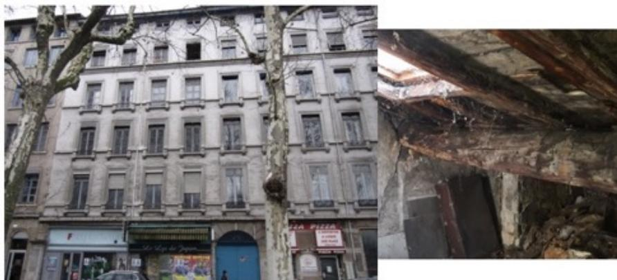
Figure 2 – Le risque d’effondrement d’une toiture
