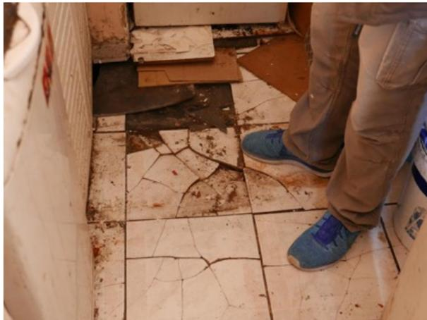
Figure 11 – Effondrement du sol suite à infiltrations
