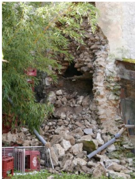
Figure 12 – Effondrement d'un mur ancien surélevé
