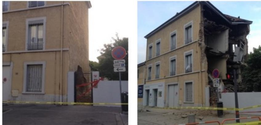
Figure 1– L’effondrement d’un mur d’immeuble
