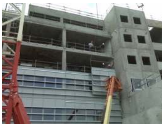
Figure 13 – Montage d'une façade-cadre
