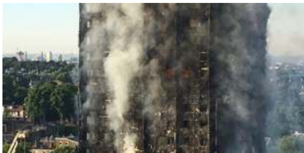
Figure 15 – Le drame de la tour Grenfell en 2017
