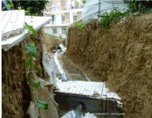
Figure 6 — Recherche de fuite en toiture-terrace jardin
