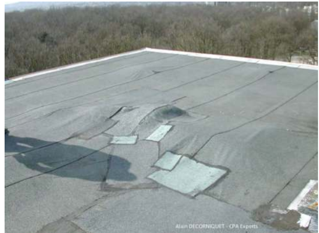
Figure 4— Déformation d'un revêtement PUR en contact avec l'eau
