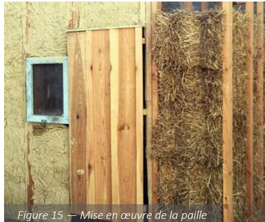
Figure 15 — Mise en œuvre de la paille
