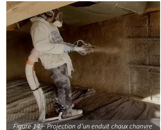
Figure 14 – Projection d'un enduit chaux chanvre
